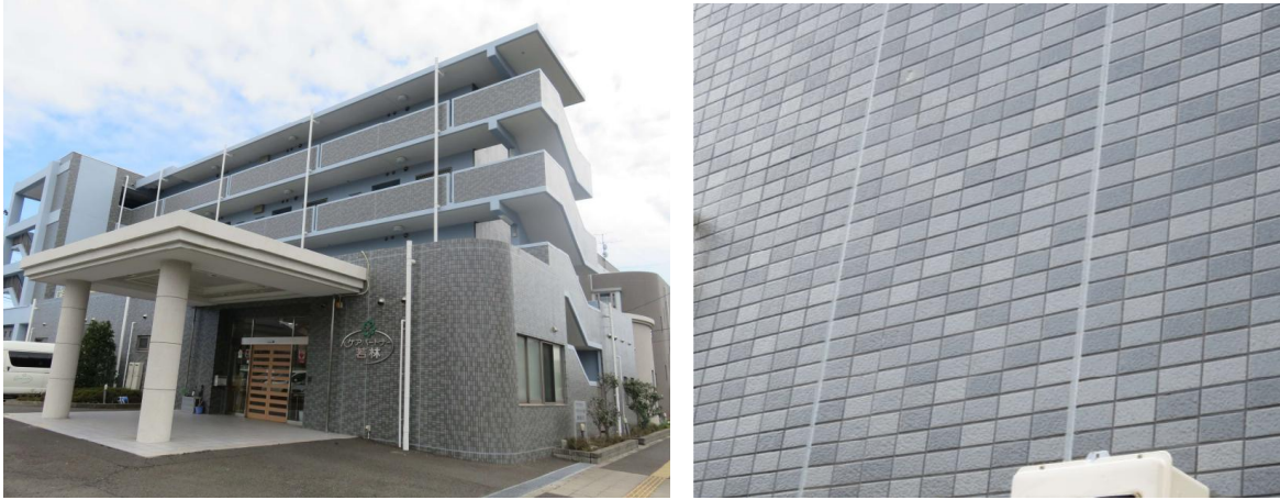
外壁タイル異常無し
